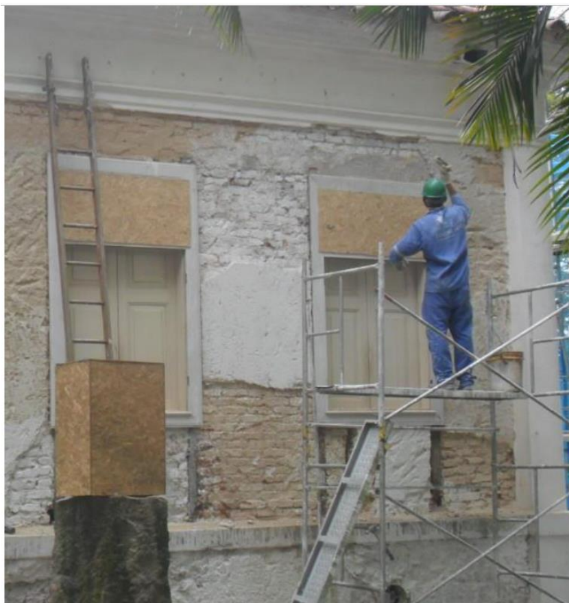
Intervenção na fachada do museu, durante a primeira fase de obras. 2017. Acervo institucional MCBC.
